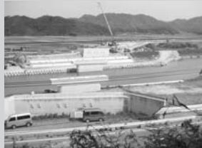
建設中の法勝寺川に架かる橋
